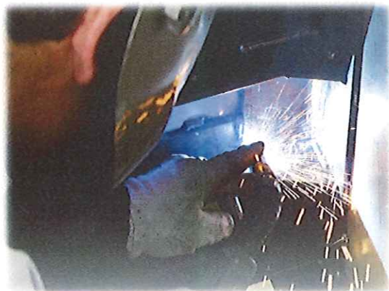
社内認定者による溶接作業
