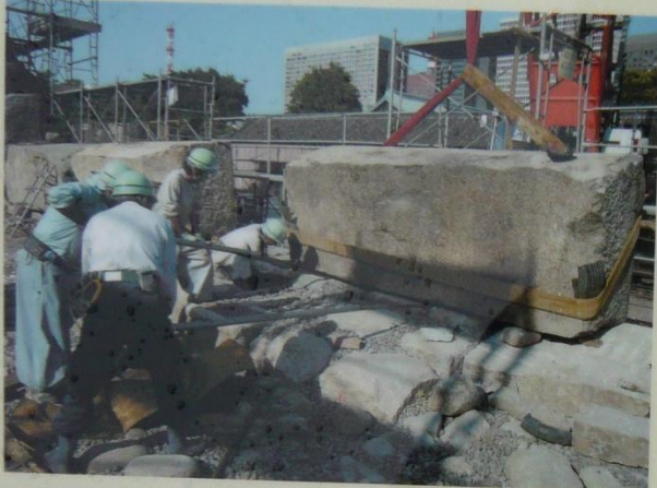
(3) 石垣背面補強石組の設置
