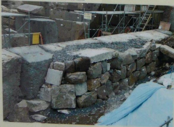
(3) 石垣背面補強石組の設置
